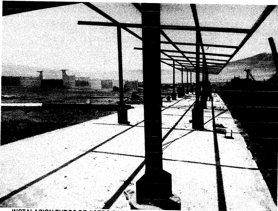
INSTALACION TUBOS DE ACERO PARA COBERTURA DE LOSA MACIZA DEL MUELLE
