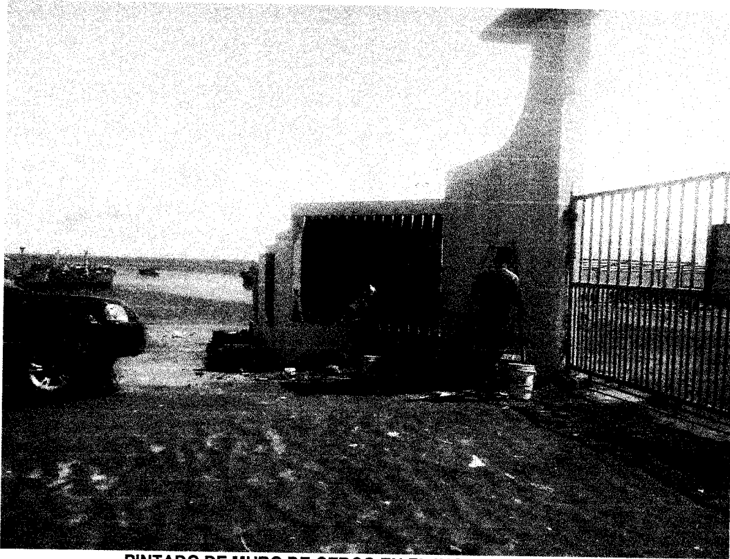
PINTADO DE MURO DE CERCO EN EL INGRESO PRINCIPAL
